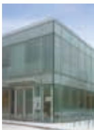
Fujitsu General (UK) Co., Ltd. (UK)
