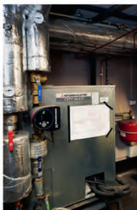
Den här kylmaskinen, en Mitsubishi City Multi med frekvensstyrd kompressor, kyler serverrum och testrum för Ceuts elmotorer. Fyra inomhusdelar är kopplade till utomhusdelen och dessa styrs individuellt.
